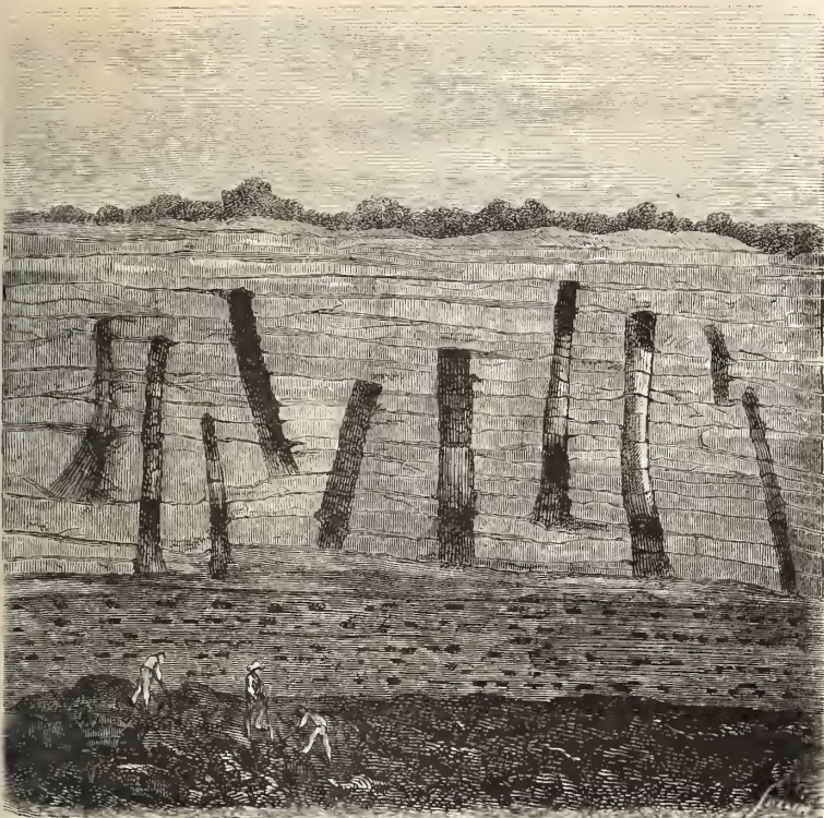
Fig. 85. Mine du Treuil, à Saint-Étienne.
